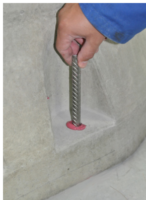
Изображение 6б: поставяне на арматурата
