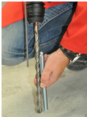
Изображение 8b: Нагласяне на дълбочината на пробиване
