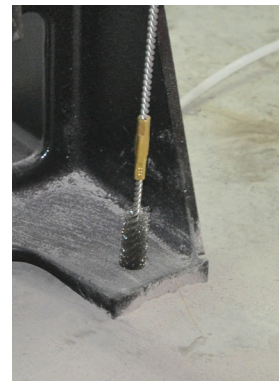
Изображение 8d: Почистване на отвора
