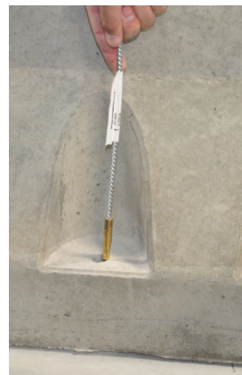
Изображение 5д: Изчеткване на отворите
