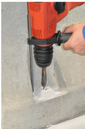
Изображение 5б: Пробиване на монтажните отвори
