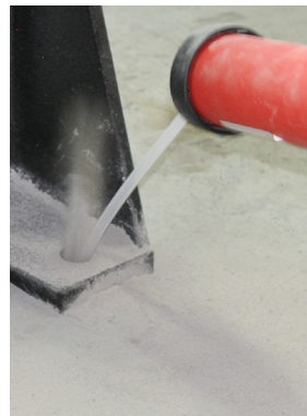
Изображение 8c: Продухване на отвора
