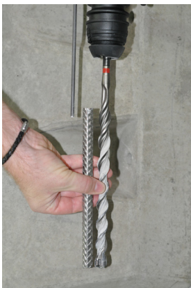
Изображение 5а: Нагласяне на дълбочината на пробиване
