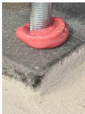
Изображение 9b: Вкарване на щифта
