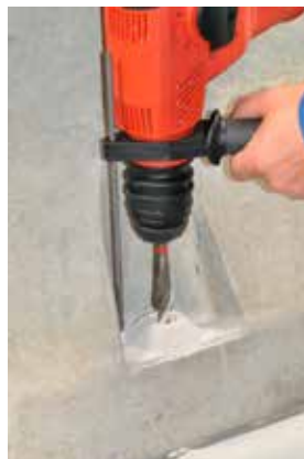
Figura 5b: Realizzare i fori di fissaggio.
