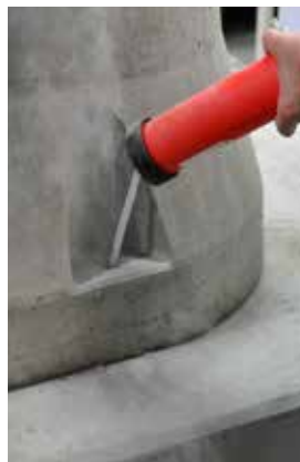
Figura 5c: Pulire il foro soffiando aria.
