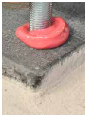
Figura 9b: Introdurre la barra filettata.
