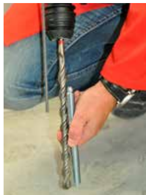
Figura 8b: Impostare la profondità di perforazione.
