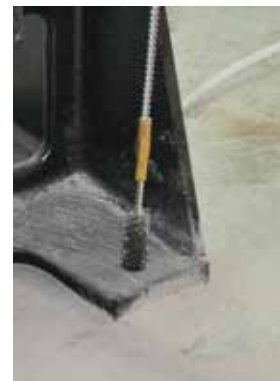
Figura 8d: Pulire il foro.
