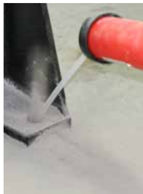
Figura 8c: Soffiare aria nel foro.
