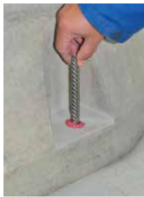
Figura 6b: Inserire l'armatura
