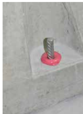
Figura 6b: Inserire l'armatura
