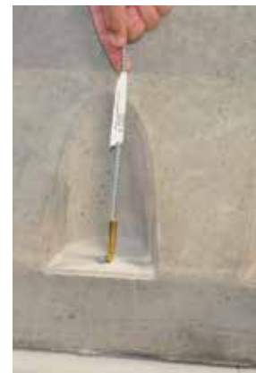
Figura 5d: Spazzolare il foro.
