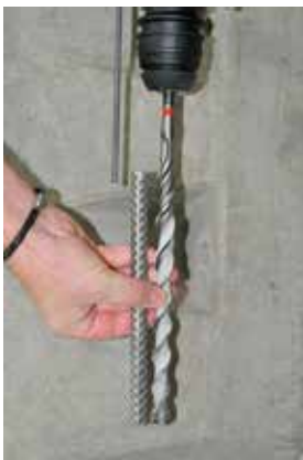
Figura 5a: Impostare la profondità di perforazione.
