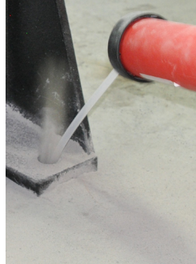
Kuva 8c: Puhalla reikä puhtaaksi
