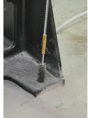
Kuva 8d: Puhdista reikä
