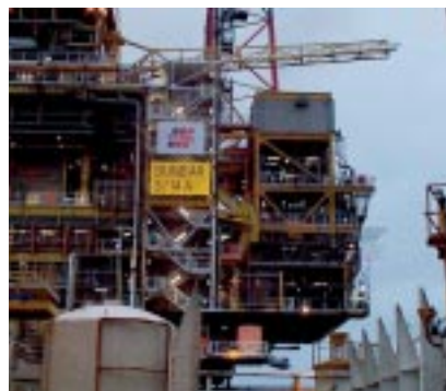
Многофазная установка присоединяется к существующей платформе.
