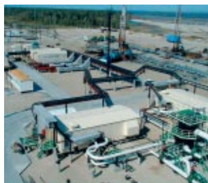
Поэтапная установка: 2 многофазных станции установлены 2 первых многофазных агрегата.
