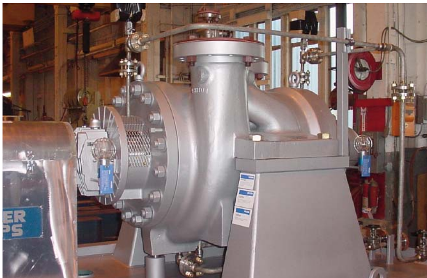
顶进顶出结构应用
