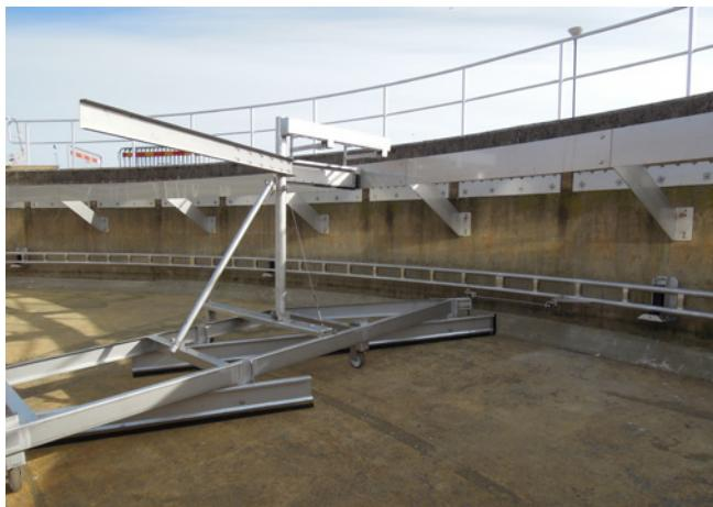
该款刮泥机可以配备圆周表面刮泥机，由底部刮泥机臂提供支撑。表面刮泥机将表面浮渣收集在浮渣盒单元中，该浮渣盒单元安装在混凝土墙上。再通过混凝土墙中的管道将浮渣盒中的污泥排走。
