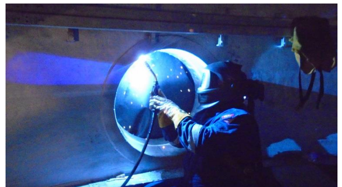
Bild 3: Reparatur von Stützen vor Ort
