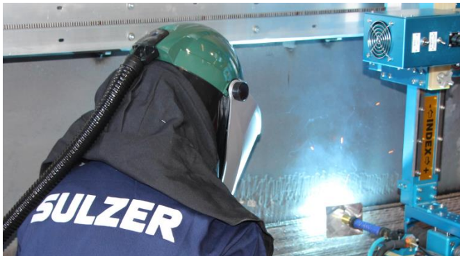
Bild 1: Automatisiertes Auftragschweißen vor Ort
