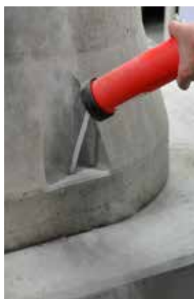
Rys. 5c Wydmuchać otwory
