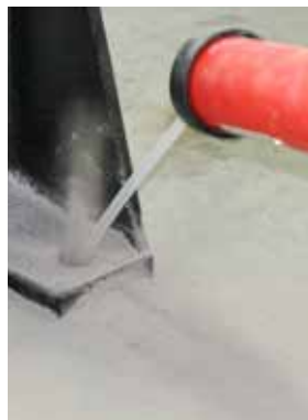
Rys. 8c Wydmuchać otwór
