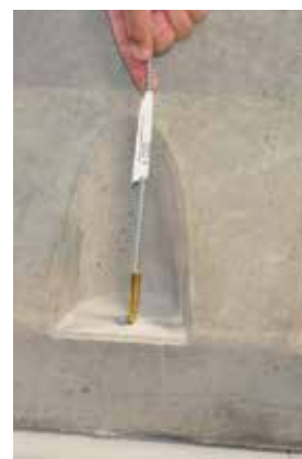
Rys. 5d Udroźnić otwory
