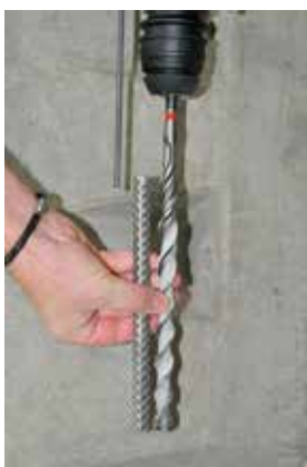
Rys. 5a Ustawić głębokość wiercenia
