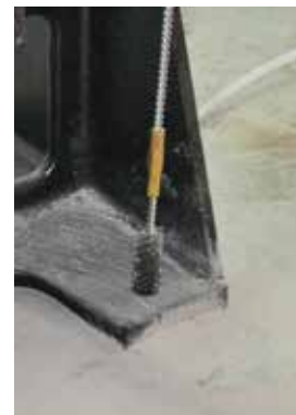
Rys. 8d Oczyszczyć otwór
