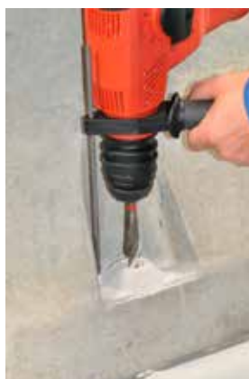
Rys. 5b Wykonać otwory mocujące
